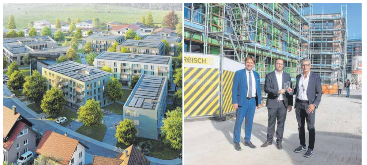
Diese Animation (linkes Bild) zeigt, wie das neue Vinzenz-Areal im Endzustand aussehen soll. In einem halben Jahr sind die Wohnungen bezugsfertig. Das Projekt soll die Generationen miteinander verbinden. Haben allen Grund beim Richtfest auf das Bisherige und Künftige anzustoßen (rechtes Bild, von links): Wangens Oberbürgermeister Michael Lang, Reisch-Projektleiter Erich Steib und Vinzenz von Paul Geschäftsführer Roy Hummel.
