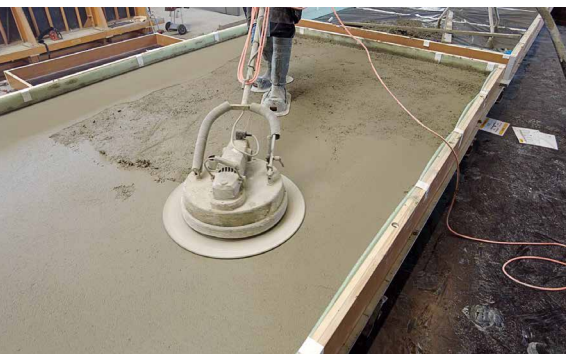
Abb. 11: Während des Glättens des RC-Estrichs [© Georg Reisch GmbH & Co. KG]
