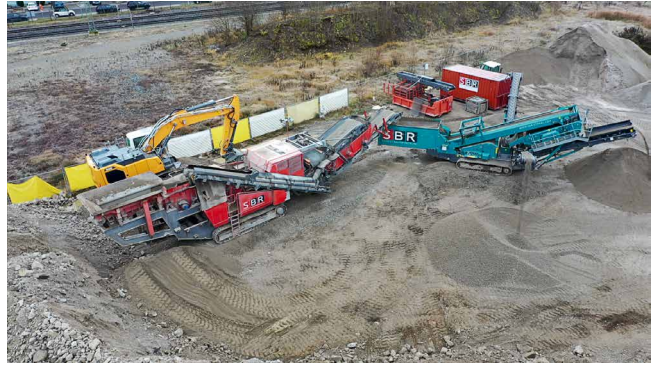
Abb. 7: Aufbereitung des Abbruchmaterials nahe der Baustelle [© Georg Reisch GmbH & Co. KG]
