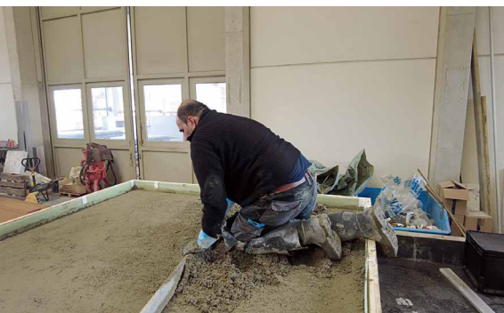
Abb. 10: Während des Verteilens des RC-Estrichs [© Georg Reisch GmbH & Co. KG]
