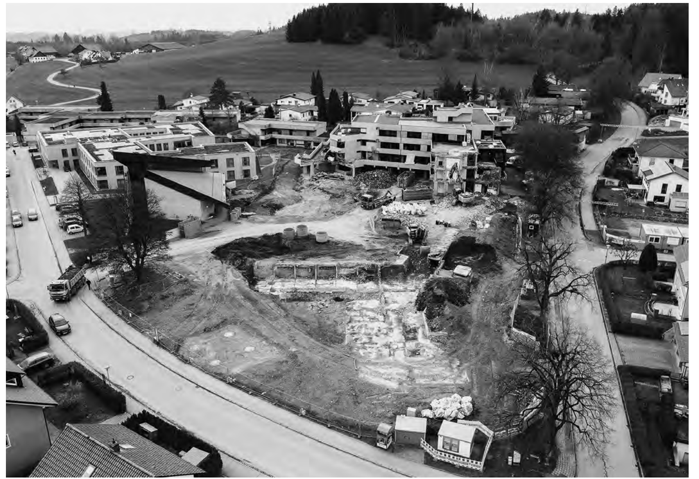
Das frühere Seniorenzentrum von St. Vinzenz wurde abgerissen. Rund 15 000 t Betonbruch wurden wiederverwendet. FOTO: GEORG REISCH
