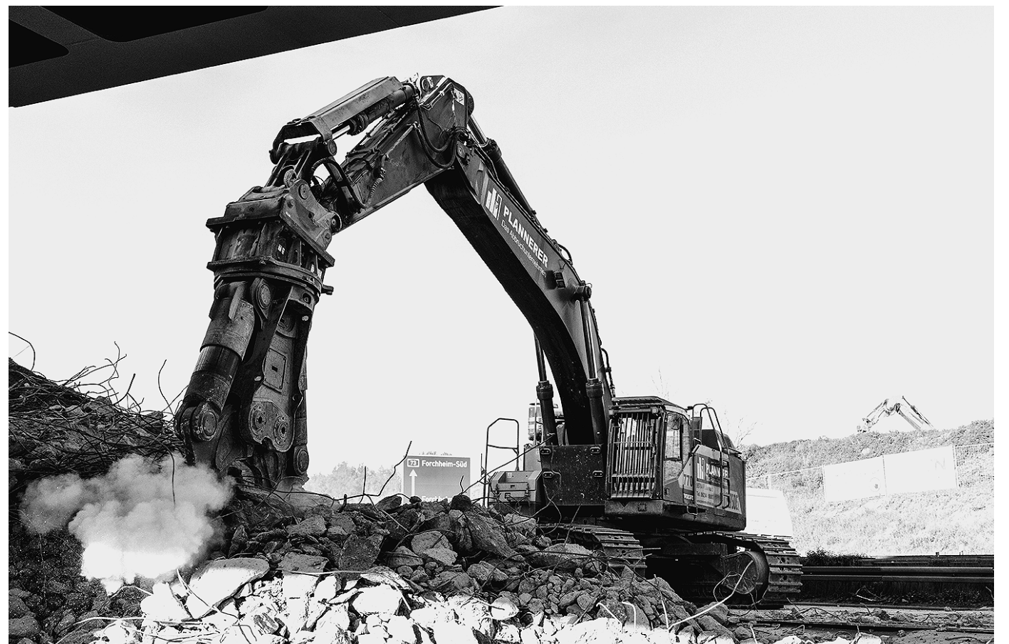
Die größte Zange im Fuhrpark mit einem Gewicht von 8250 kg wurde von einer 6650 kg schweren CC65R unterstützt. FOTO: PLANNERER
